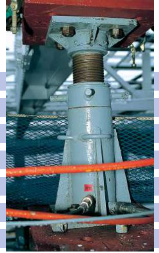
旧橋頂上部軸力受替解体工事 ジャッキUP、DOWN工事
