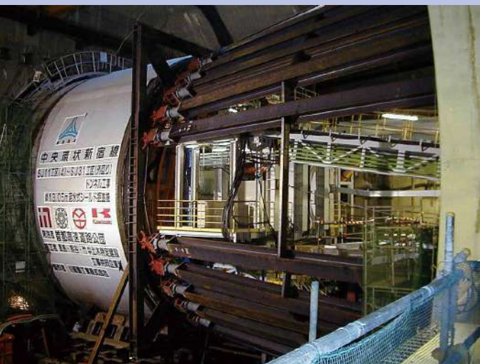
シールドマシンバックトラス反力受け工事
