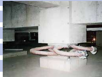
免震装置交換工事
