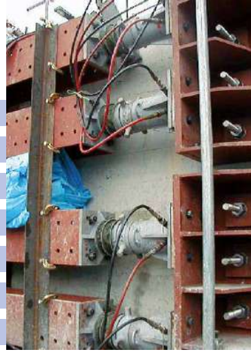
旧橋頂上部軸力受替解体工事 ジャッキUP、DOWN工事
