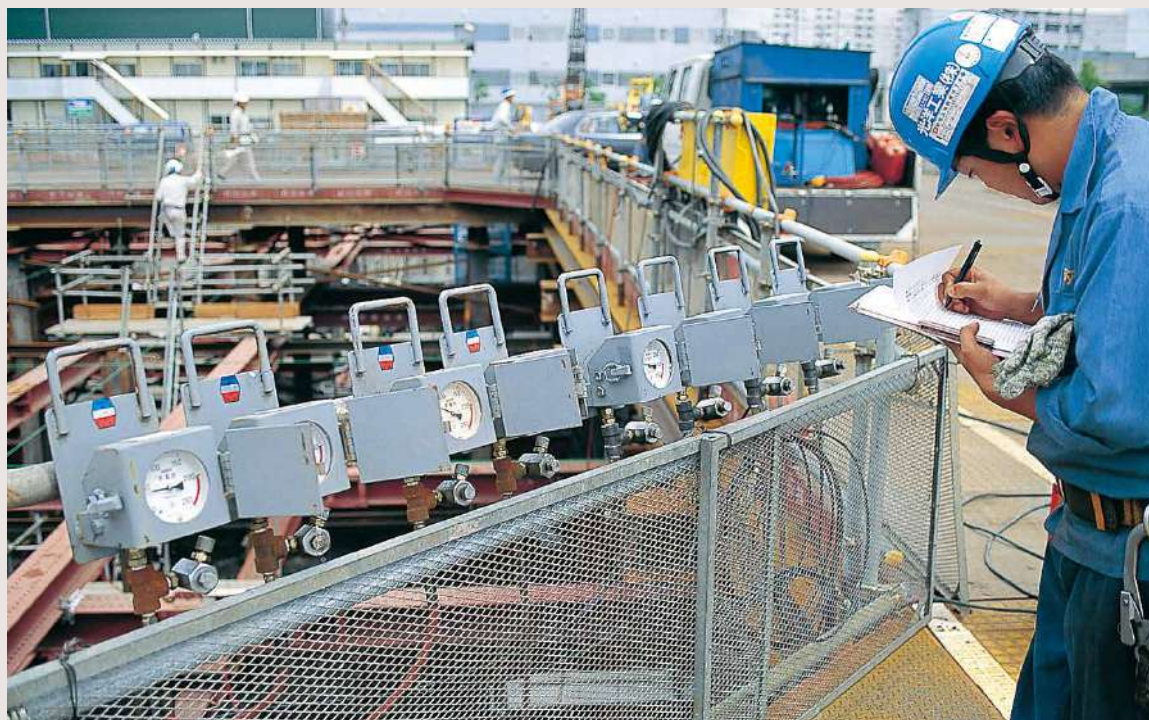
集中管理による土圧計測例
