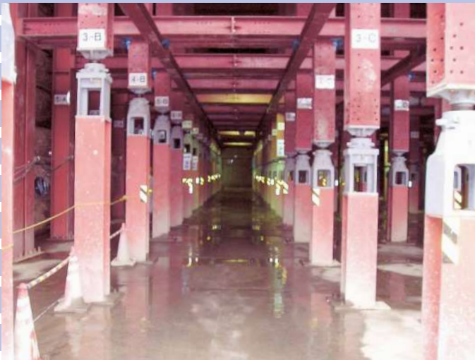
パイプルーフ工法
