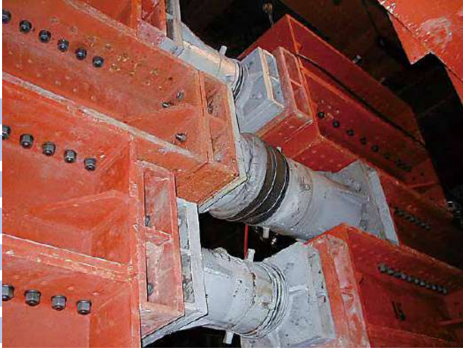
特殊プレロード工事
