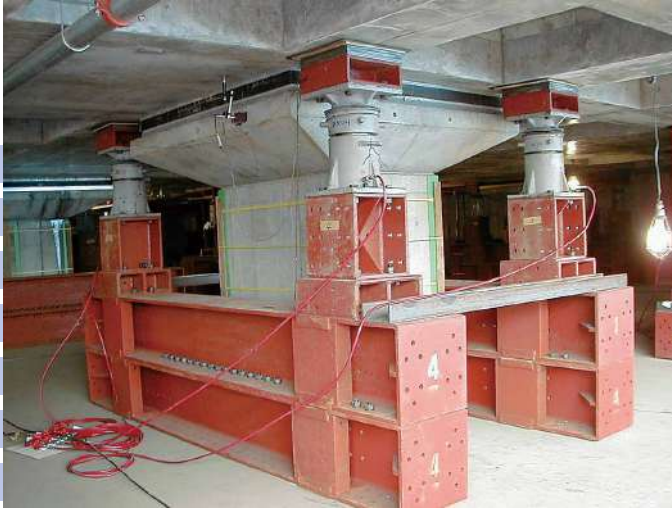
免震装置交換工事
