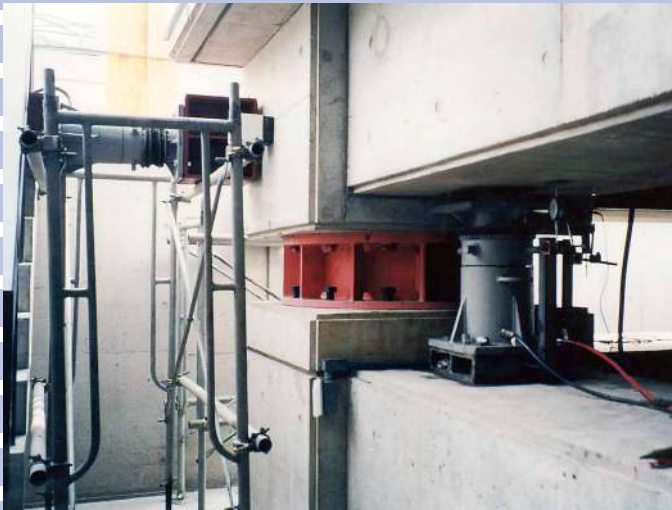
免震装置交換工事
