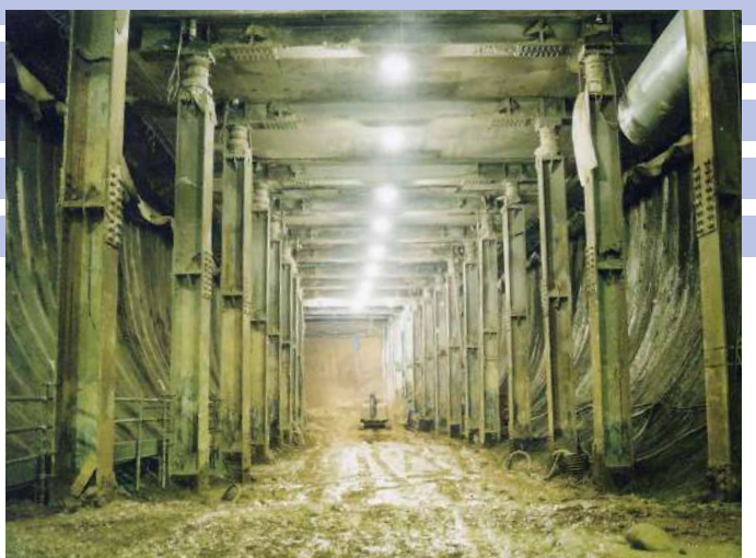
トンネル躯体受替工事
