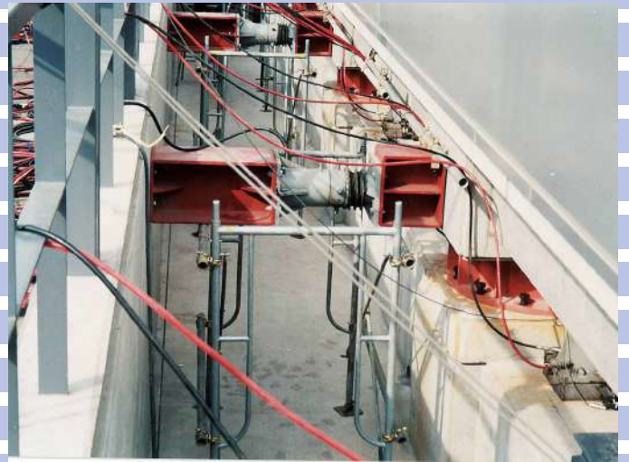
免震装置交換工事
